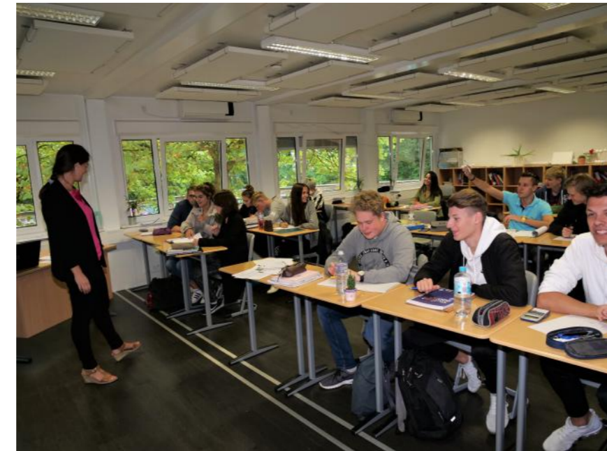
oben und rechts: unsere Containerräume, speziell abgehängte Decken für eine gute Akustik, gleichmäßige Ausleuchtung durch besondere Deckenleuchten, Klimaanlage (über den Fenstern)
